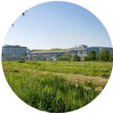
GREENTECH PARK PRINCIPLE 6 Lokale energie Voor valorisatieprocessen en voor het verwarmen van gebouwen maakt GreenTech Park zo veel mogelijk gebruik van restwarmte die beschikbaar is bij bedrijven in de directe omgeving, zoals bij het Rabobank Datacenter en VION. De benodigde elektriciteit wordt op het terrein zelf duurzaam opgewekt.
